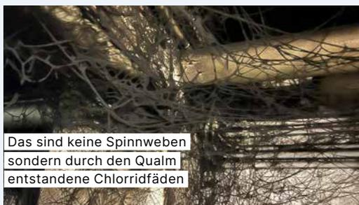
Das sind keine Spinnweben sondern durch den Qualm entstandene Chlorridfäden
